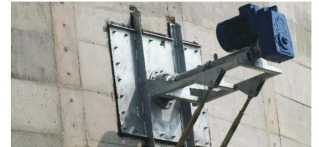
±25° Verstellung in der vertikalen und horizontalen Achse durch hydraulische Handpumpe
